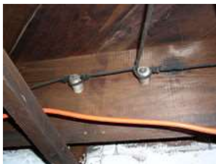
سیم کشی دستگیره و لوله (کابل نارنجی یک سیم اتصال نامرتب است)
