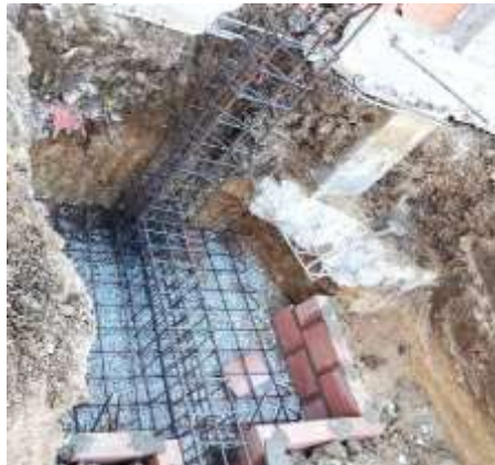
شکل: فوندانسیون یا فوندانسیون تسمه ای
