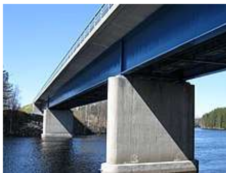
یک تیر فلزی به شکل من در زیر یک پل
