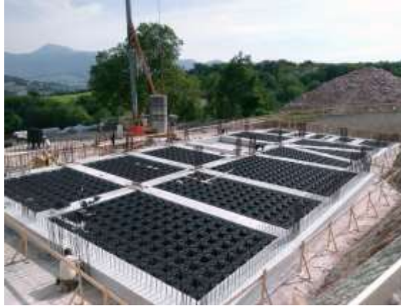
شکل ۲: قالب بندی فوندانسیون
