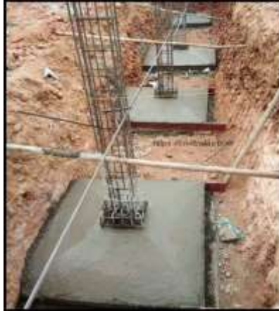
شکل: تصویر فونداسیون کم عمق جدا شده
